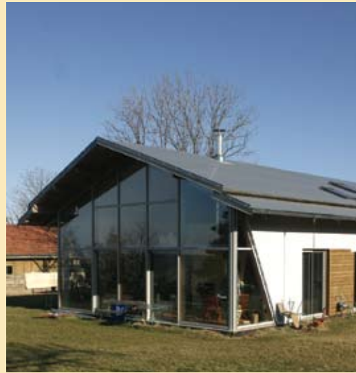
Un mur pignon entièrement vitré.
