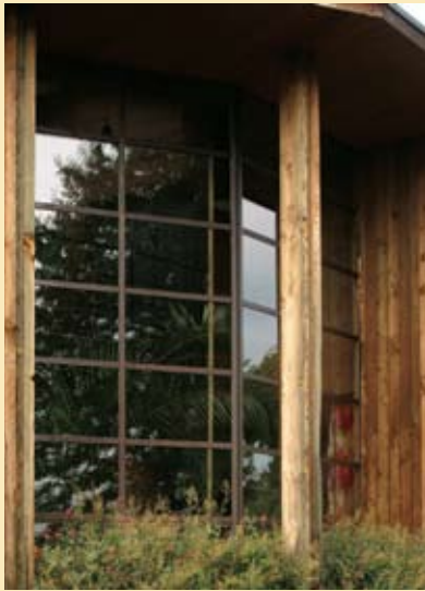
Une verrière protégée par un débord de toit.
