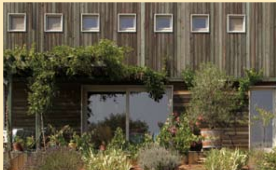
... ou des façades plus lisses, ou priment le rythme des ouvertures, la présence de la végétation.
