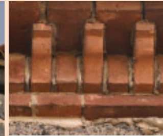
Corniche de briques à modillons.
